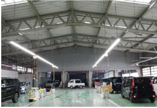
◇工場の照明器具LED化工事（ビーム）他
